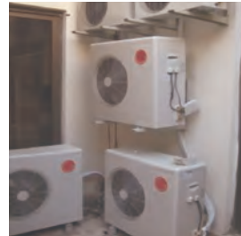
اشتباه در نصب واحدها در کنج دیوار (مکان یابی)
